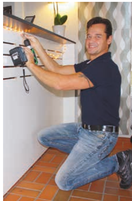
Björn Wredenmark, ansvarig för fastighetsskötseln i Nybos bostäder, får delvis nya förutsättningar för underhållsarbetet när försäljningen av Nybos fastigheter säljs i mars.
