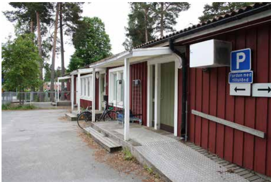
Arbetsmiljön ska bli betydligt bättre på Wincklerska förskolan och Gammeltorps förskola, när de gamla uttjänta ventilationsaggregaten byts ut.
