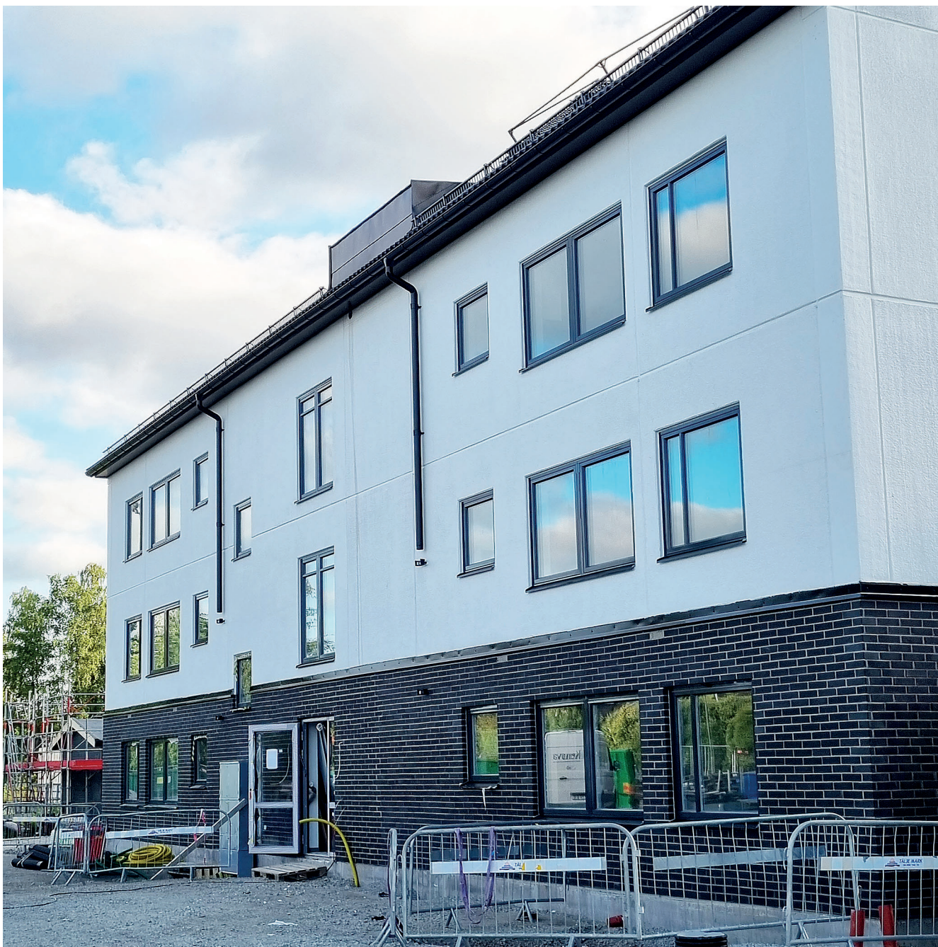
Skogsvägens etapp ett välkomnar inte bara tidigare hyresgäster, även nya från bostadskön får plats eftersom lägenhetsbeståndet utökats.
